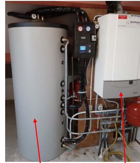
Buffervat zonneboiler, condenserende ketel
